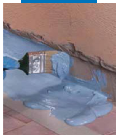
Нанесение Mapelastic AquaDefense кистью на стык между полом и стеной перед укладкой Mapeband
