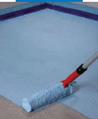
Нанесение первого слоя Mapelastic AquaDefense на стяжку
