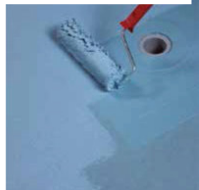
Нанесение валиком второго слоя Mapelastic AquaDefense
