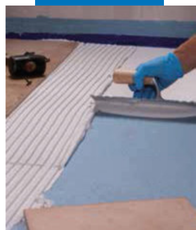
Приклеивание плитки на Mapelastic AquaDefense
